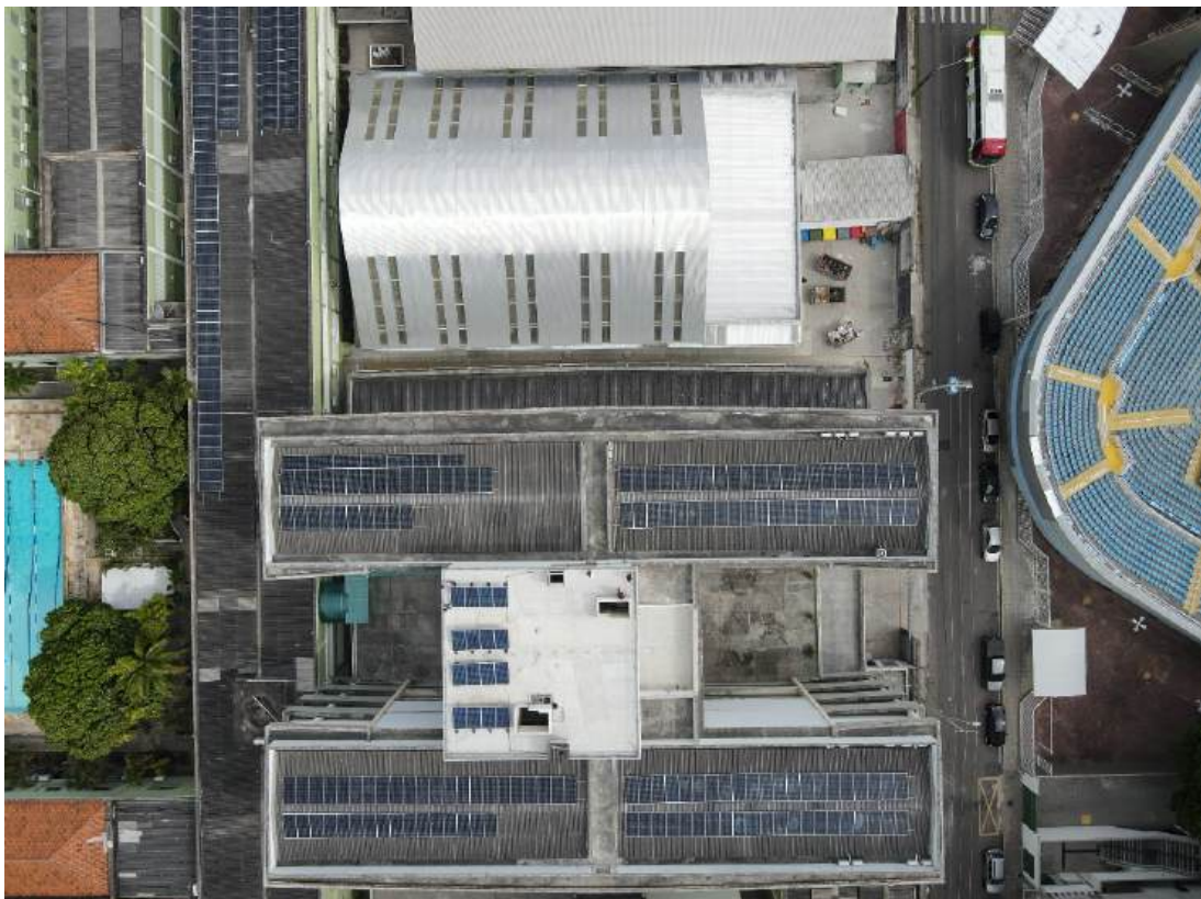
Figura 15 - Usina solar “Bloco Didático”
