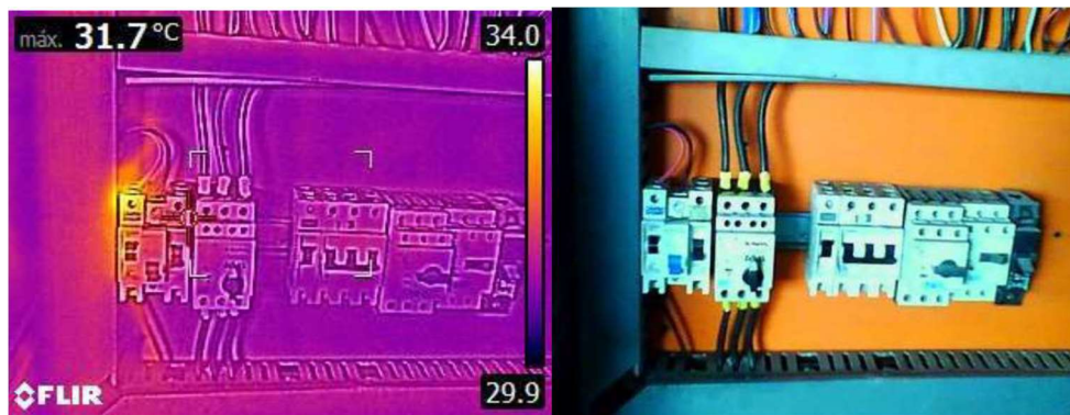
Figura 10 – Exemplo de Isoterma evidenciando o ponto com temperatura acima de 32°C
